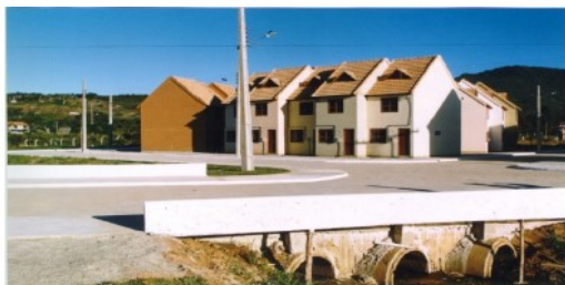
Figura 1 – Conjunto Habitacional Vila União
